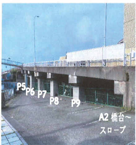
橋脚P5～P9の一部(5.7㎡)
